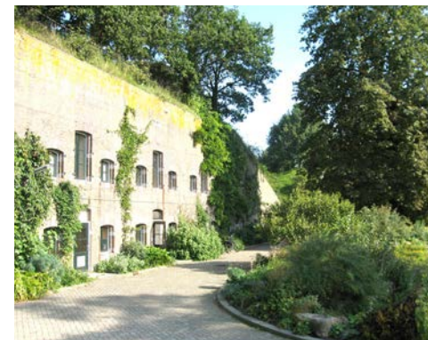
Werk aan de Hoofddijk in De Uithof
