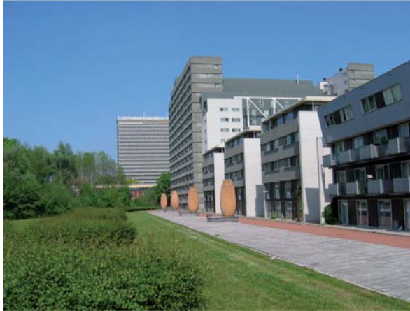
Van Unnikgebouw en Studentenhuisvesting Cambridgelaan. Architect Rudy Uytenhaak, oplevering 2001.
