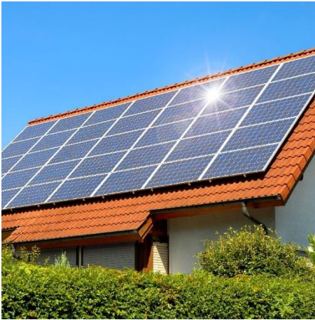
Zonnepanelen op dak
