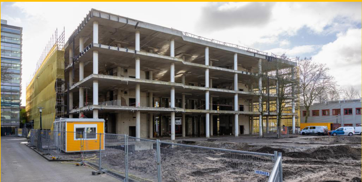
Foto: sloop aardwetenschappengebouw
